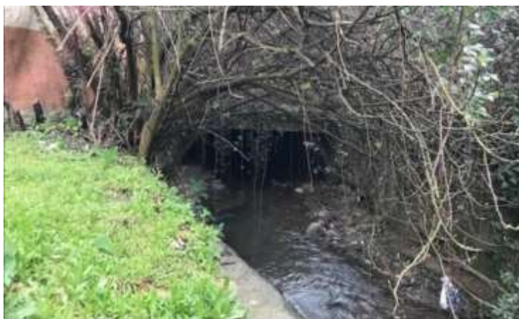
Fotografía nº4. Entrada a la cobertura de la calle Goikoplaza
