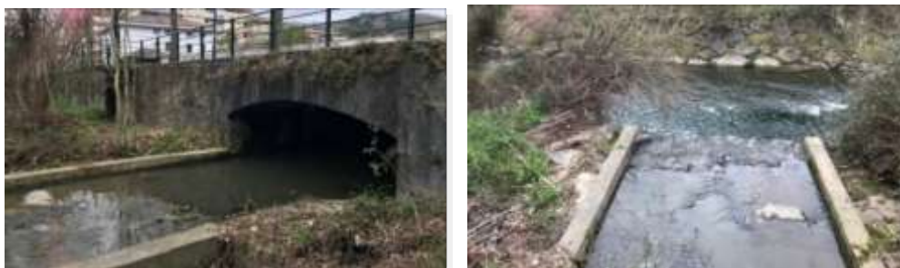
Fotografía nº5. Salida de la cobertura y confluencia con el río Nervión
